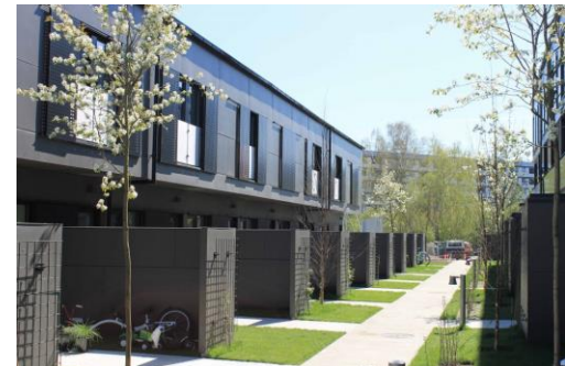
Case 3 - AlmenBolig+: Grøndalsvænge Allé, Vanløse, Boligselskabet KAB, ONV Arkitekter, opført 2012
