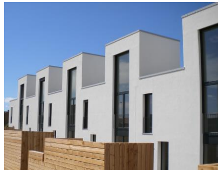
Case 2 - Energi: Lærkehaven, afd. 35, Lystrup v. Århus, Boligforeningen Ringgården, SHL Arkitekter, opført 2010
